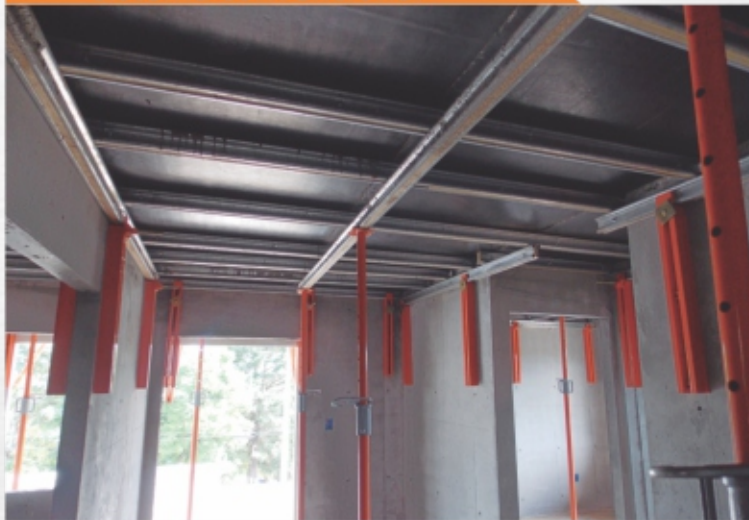
10. Montagem das lajes com sistema convencional
