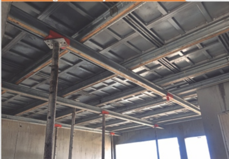
9. Montagem das lajes com fôrma
