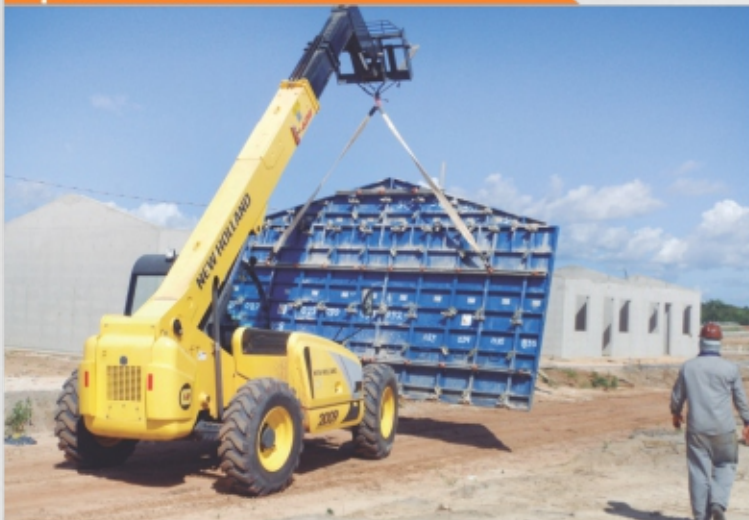
7. Transporte mecanizado dos painéis com munck
