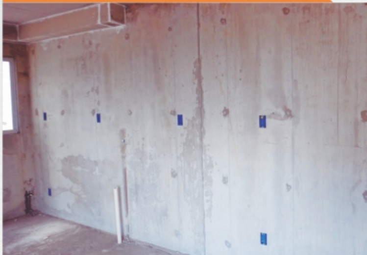
8. Instalações elétricas e hidráulicas embutidas
