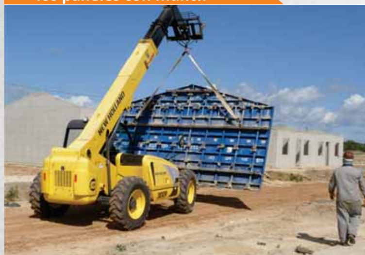
7. Transporte mecanizado de los paneles con muncck
