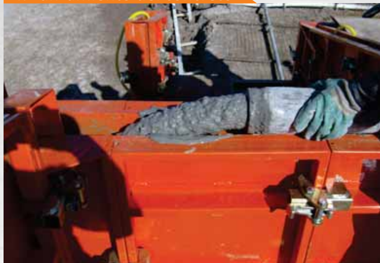
4. Lanzamiento del concreto
