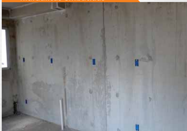
8. Instalaciones eléctricas e hidráulicas embutidas
