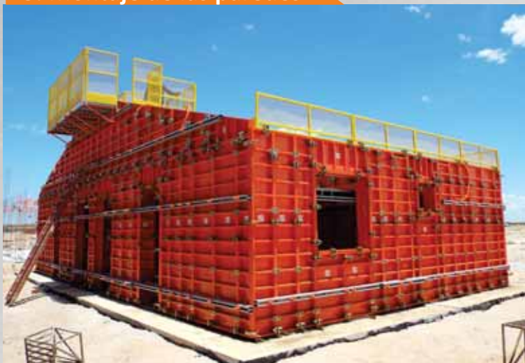
3. Montaje de las paredes
